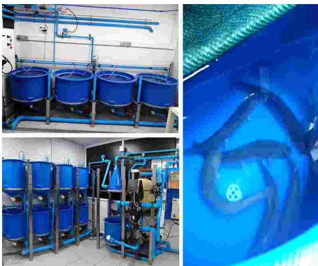
Figura 1: Sistema de flujo continuo y RAS para la mantención de truchas. El panel izquierdo superior muestra los tanques de ~600 L en continuo flujo de agua de mar. La imagen izquierda inferior muestra el sistema RAS. La imagen de la derecha muestra los tanques RAS conteniendo 8 truchas a una densidad promedio de ~13 kg m -3 cada uno.
