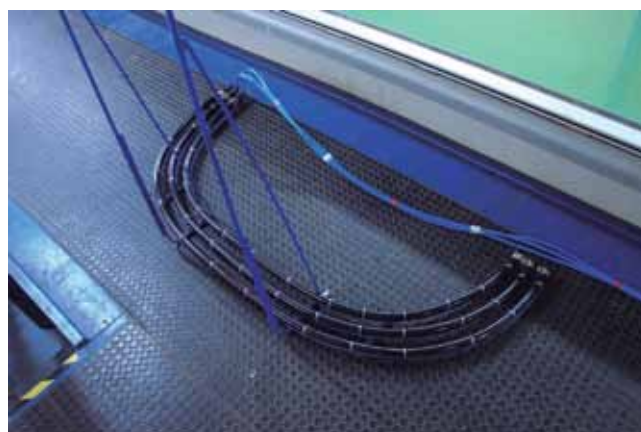
Figura 5: Difusores montados en la estructura de acero.
