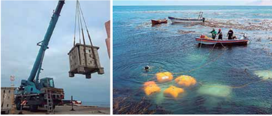
Figura 6. Instalación de arrecifes artificiales.
