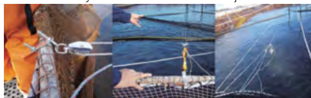
Figura 3: Imágenes del sistema de cabos instalado en la balsa jaula.
