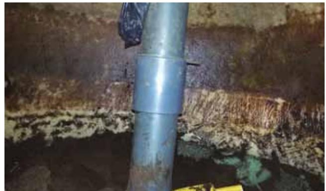
Imagen 2. Interior de cilindro de filtración con demarcación de biofilm.
