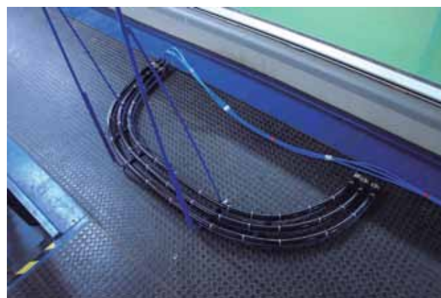
Figura 5: Difusores montados en la estructura de acero.
